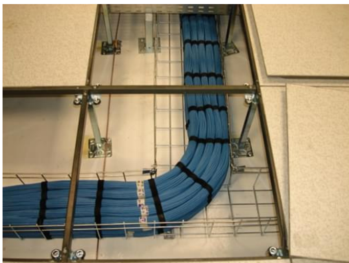
Fig. 6: Detalhe da organização de cabos UTP em leito.
