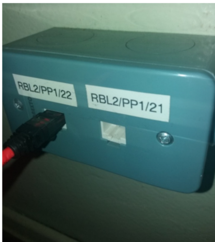
Fig. 7: Ponto de rede x2 devidamente identificado.
